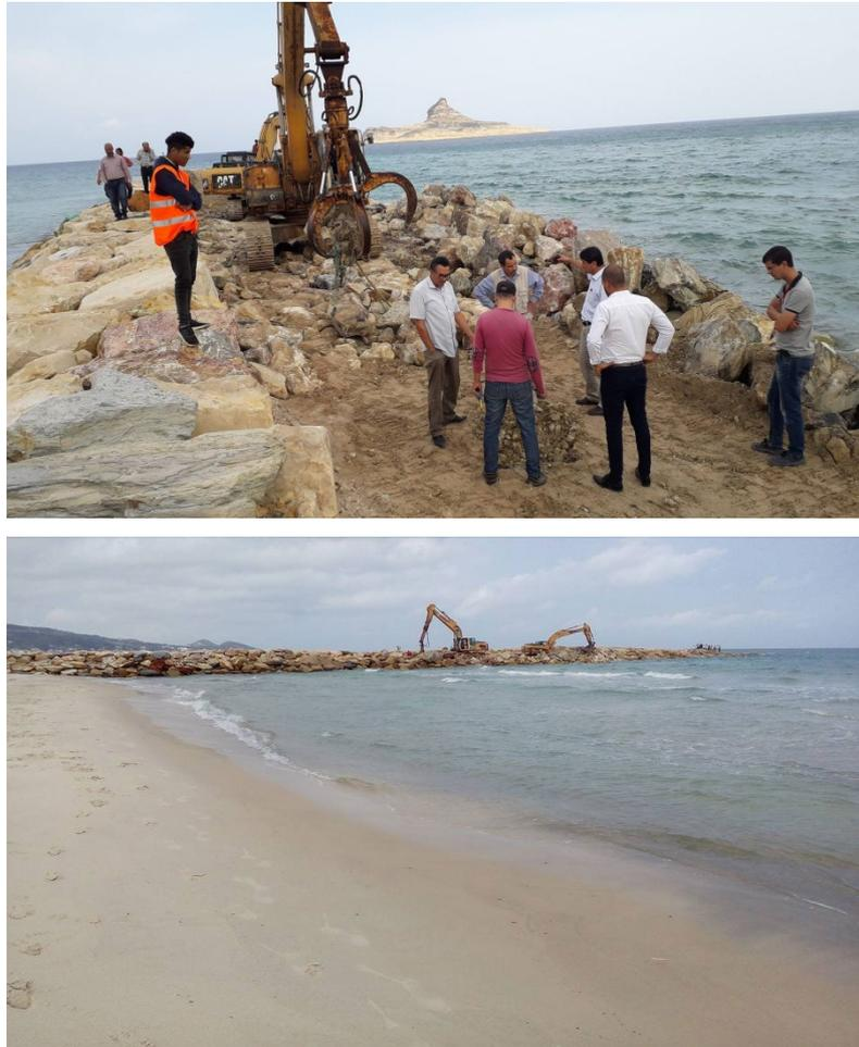
**Figure 45.** Travaux de l'édification de l'épi de protection de la plage de Rafrat (APAL, 2018)
