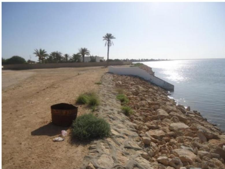
**Figure 47.** Enrochement implanté sur l'emplacement de l'une des rares plages de l'archipel à la suite d'une accélération récente de l'érosion de la côte touristique de Sidi Fraj (photo, Oueslati, 2015).
