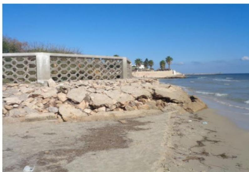
**Figure 17.** Impact de l'aménagement du port d'El Kantaoui sur le secteur situé au Sud (photo, F. Brahim, 2017).
