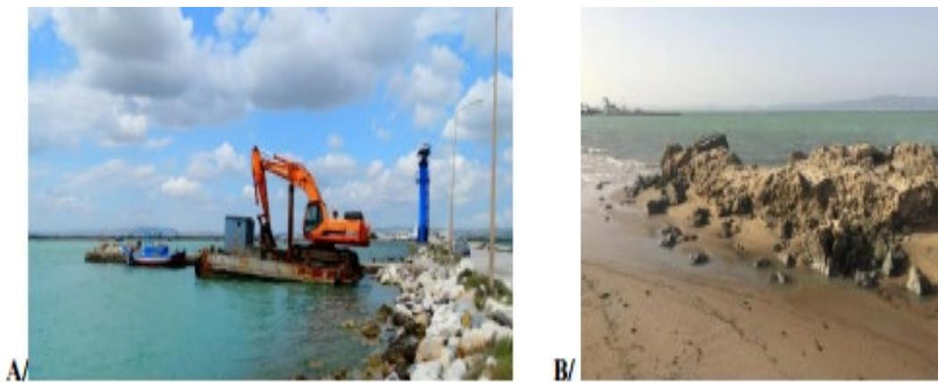
**Figure 56.** Dragage du port de Kalaat Landalouss(mars 2016). A/ Dragage (mécanique à pelle) ; B/ Mise à dépôt à l'entrée du port, passe de la lagune.
