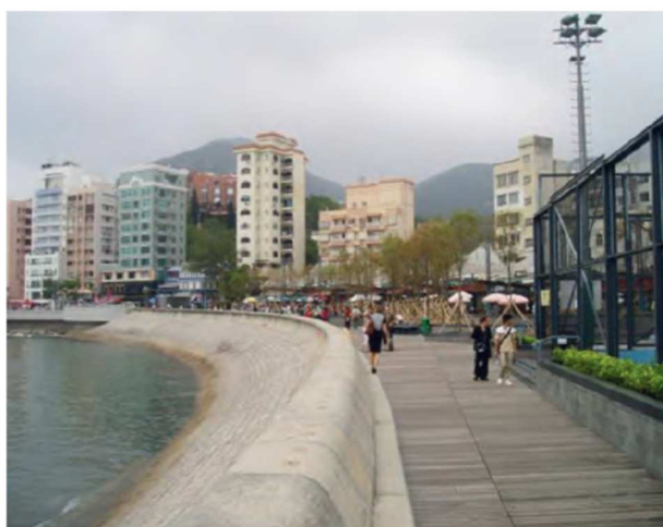
Slika 6.31: Obalni zid u Hong Kong-u. Na ovoj slici se jasno vidi da ako se ne riješi učinkovita odvodnja površinskih voda da će se za vrijeme kiša iza zida stvoriti jezero. (Izvor: Engineers Australia, 2012.)
