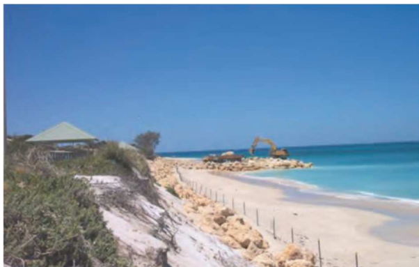
Slika 6.13: Izvedba pera (Izvor: Engineers Australia, 2012.)
