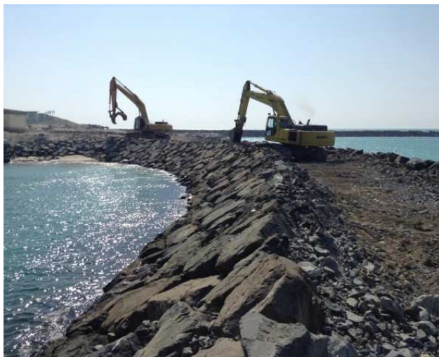
Slika 6.2: Primjer tipične izvedbe obalnog zida (Izvor: http://estruct.com.au/waterways/revetment-walls/rock-armour/ )
