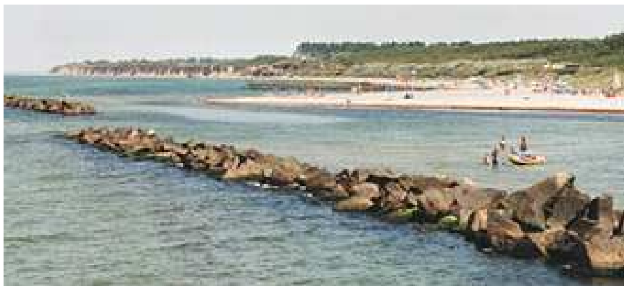
Slika 6.23: Primjer razbijača valova položenih paralelno s obalom (Izvor: http://www.treffpunkt-ostsee.de/english/baltic-sea/coastal-protection-structures.php )
