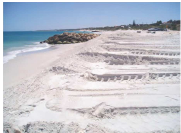
Slika 6.12: Neravnine na nasutim plažama koje mogu dovesti do ozljeda korisnika (Izvor: Engineers Australia, 2012.)
