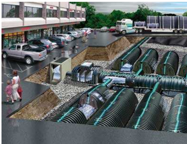
Slika 6.30: Izvedba retencije u odvodnom sustavu - zadržavanje vode u sustavu, usporavanje otjecanja. (Izvor: http://prod5.dailycommercialnews.com/article/id24165 )
