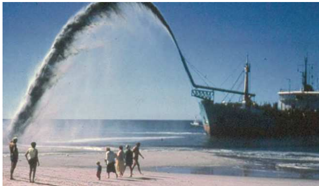
Slika 6.9: Primjeri obnavljanja plaža nasipanjem strojevima za jaružanje (Izvor: Engineers Australia, 2012.)
