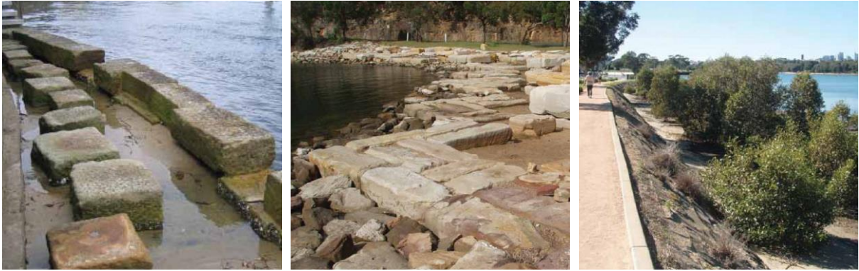
Figure 11 : Exemples de digues respectueuses de l'environnement (Environmentally Friendly Seawalls, 2009)
